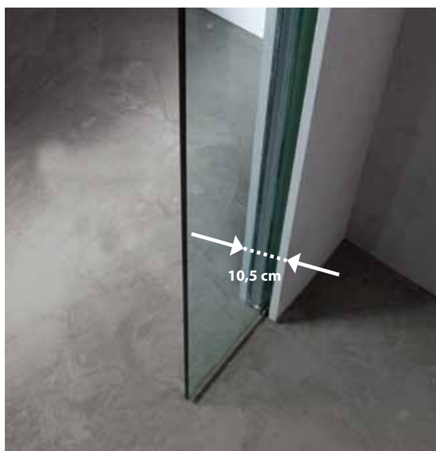
Spessore parete 10,5 cm Wall thickness 10.5 cm
