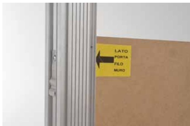
Zanca chiusa inserita all'interno del profilo Closed lug fitted inside profile bar
